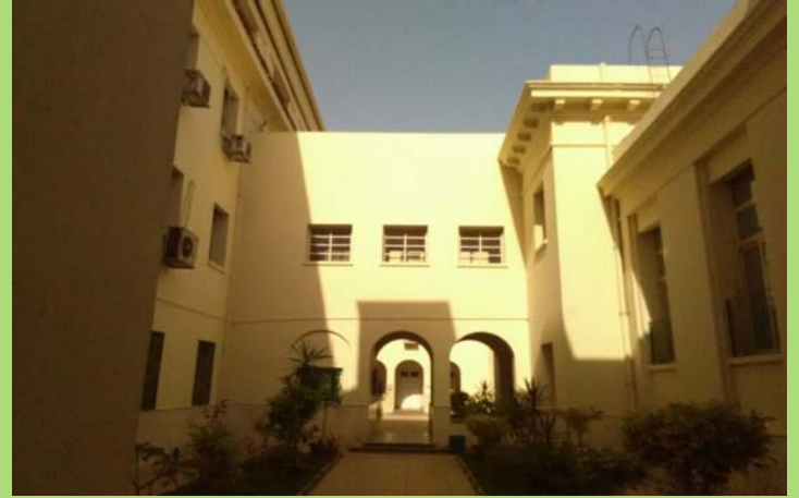
الواجهات الداخلية للمبنى بعد انتهاء أعمال الدهانات
