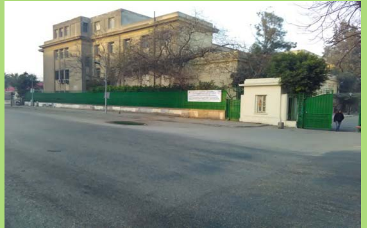
مبنى كيمياء قبل أعمال الدهانات
