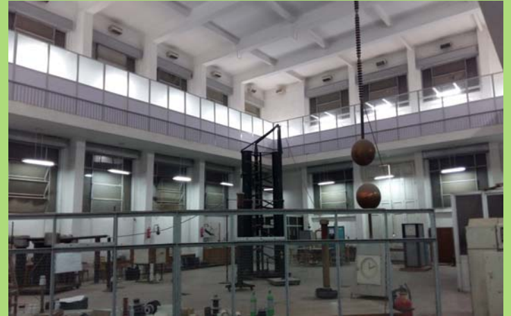
معمل " هندسة القوى المفتوح " بمبنى ١٦ بعد الانتهاء من أعمال الإحلال والتجديد
