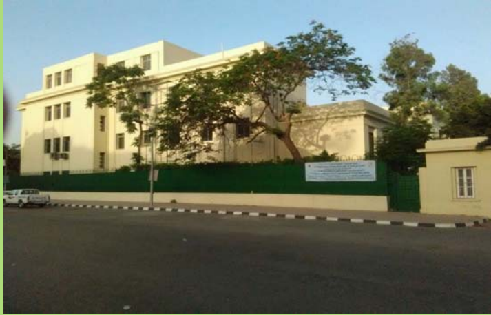
الواجهة الشرقية للمبنى بعد إنتهاء أعمال الدهانات
