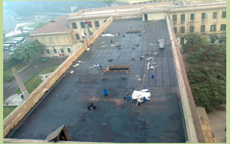
وضع المواد العازلة فوق السقف الخرساني لمبنى الإدارة
