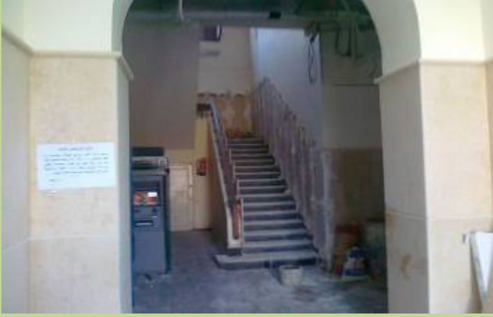
أعمال الاحلال والتجديد لسلام مبنى الادارة
