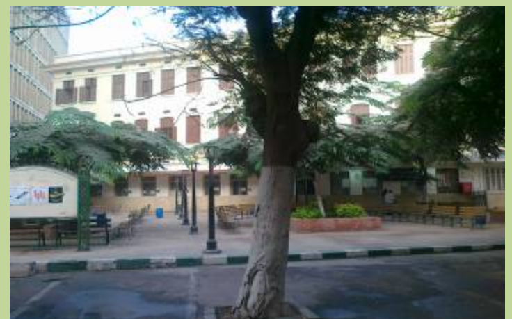
الواجهة الخلفية لمبنى الإدارة بعد اعمال الاحلال والتجديد
