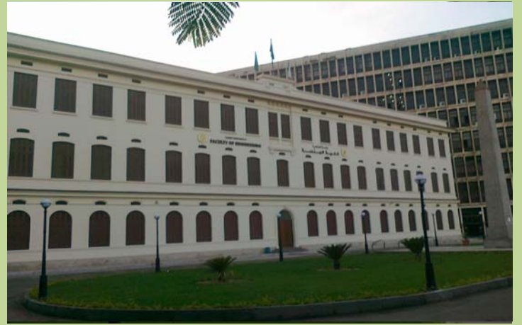
الواجهة الأمامية لمبنى الإدارة بعد اعمال الاحلال والتجديد
